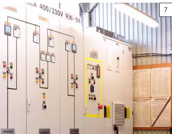
фот. 7 Распределительное устройство собственных нужд RW 400/230 В
